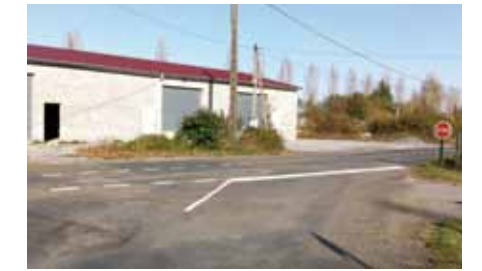
Sécurisation de la sortie du chemin du four à chaud (face à l'ancienne gare).
