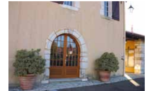
Remplacement de la porte d'entrée de la salle des mariages.
