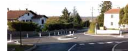
Aménagement du giratoire Oyhanto.
