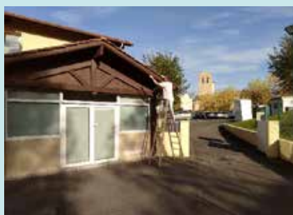
Réfection des peintures des avant-toits.
