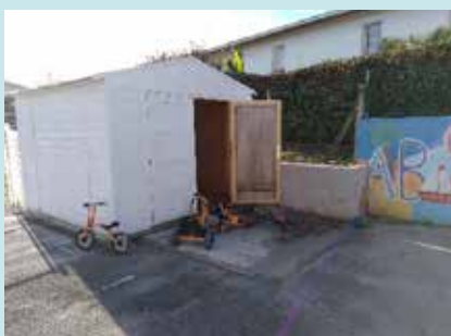
Construction d'un abri à vélo par les agents du service technique.
